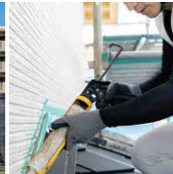
外壁補修工事
