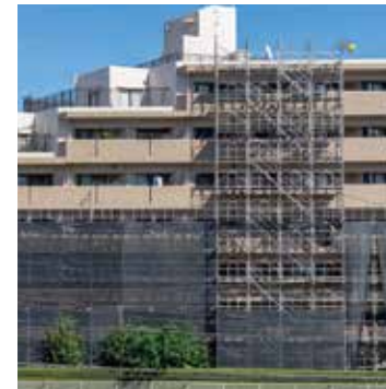
外壁補修工事
